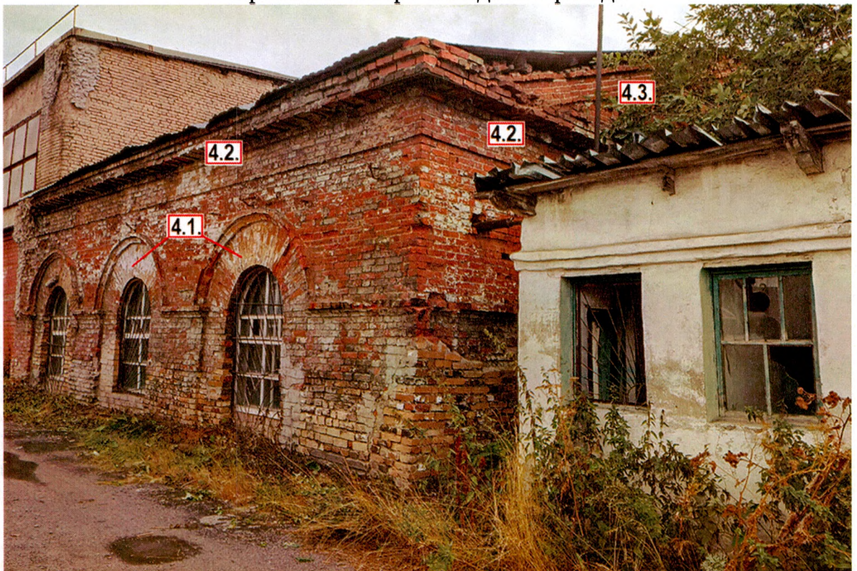
Фрагмент северо-западного фасада
