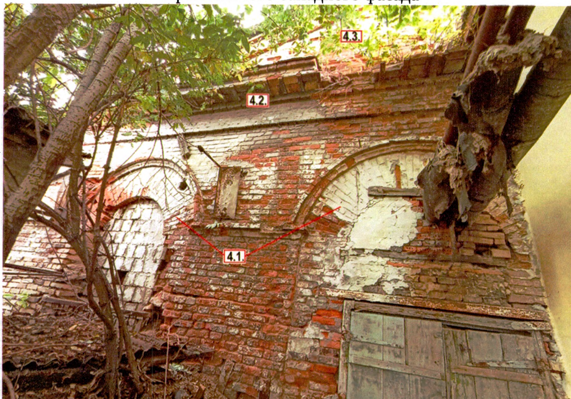
Фрагмент юго-западного фасада
