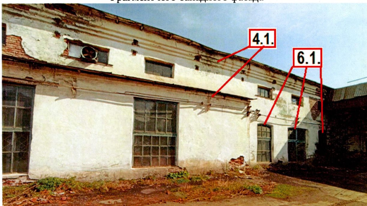
Фрагмент юго-западного фасада
