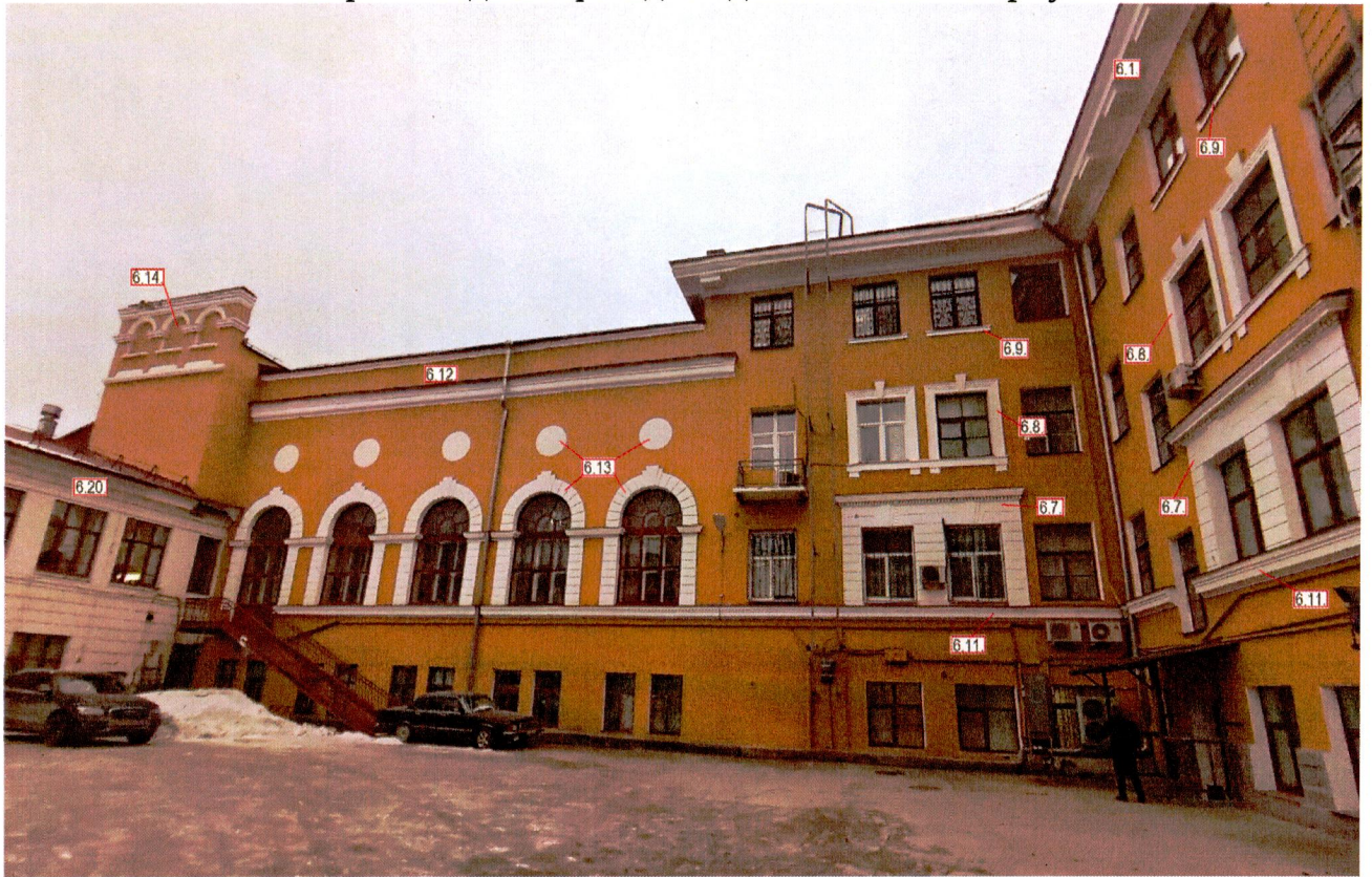
Северо-западный фасад соединительного корпуса
