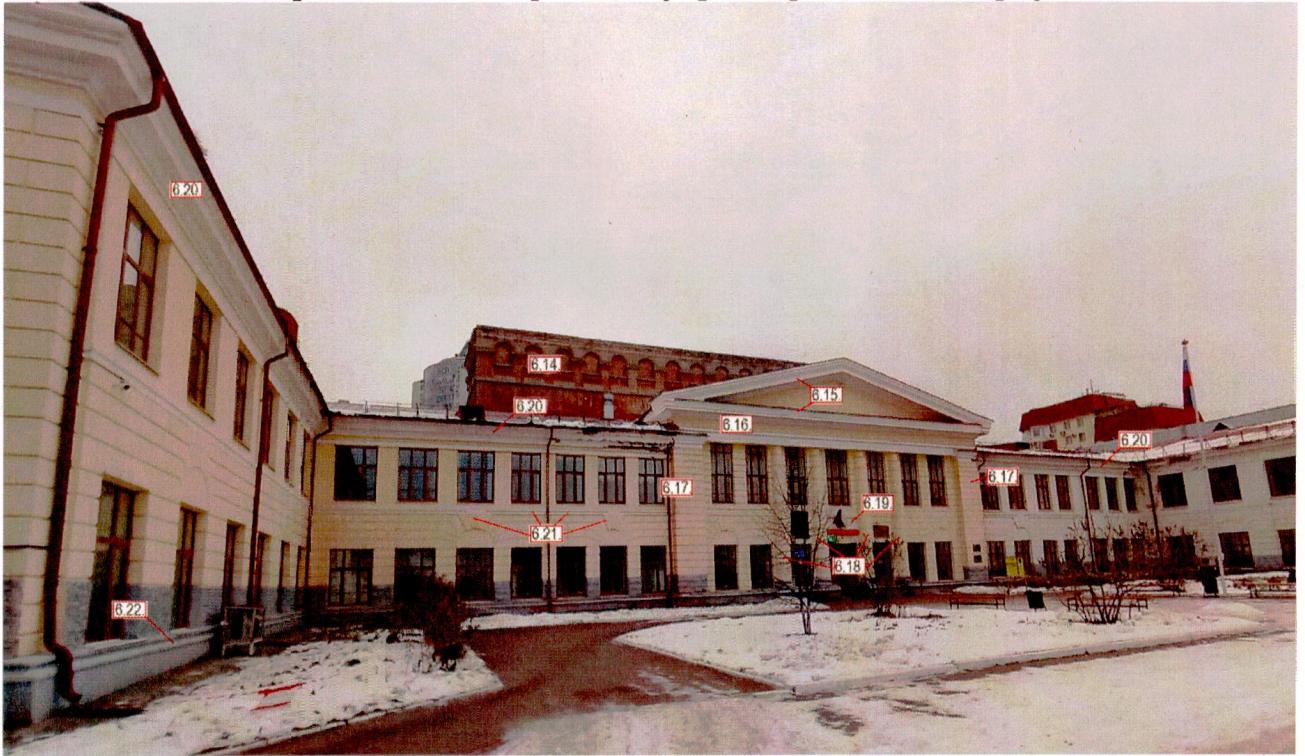
Северо-восточный фасад внутриквартального корпуса
