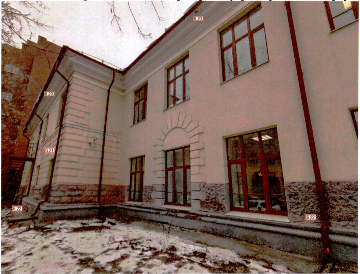
Юго-восточный фасад восточного пристроя внутриквартального корпуса
