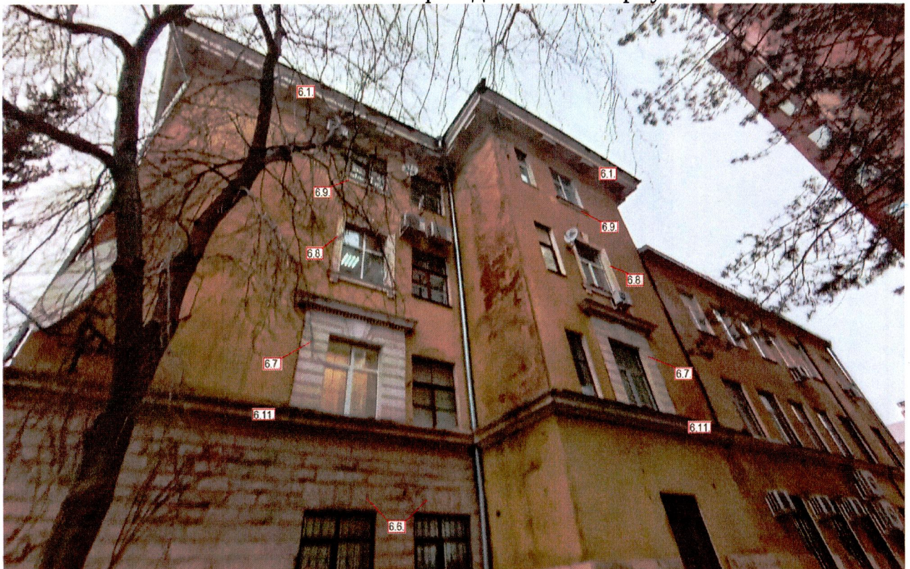
Юго-восточный фасад главного корпуса
