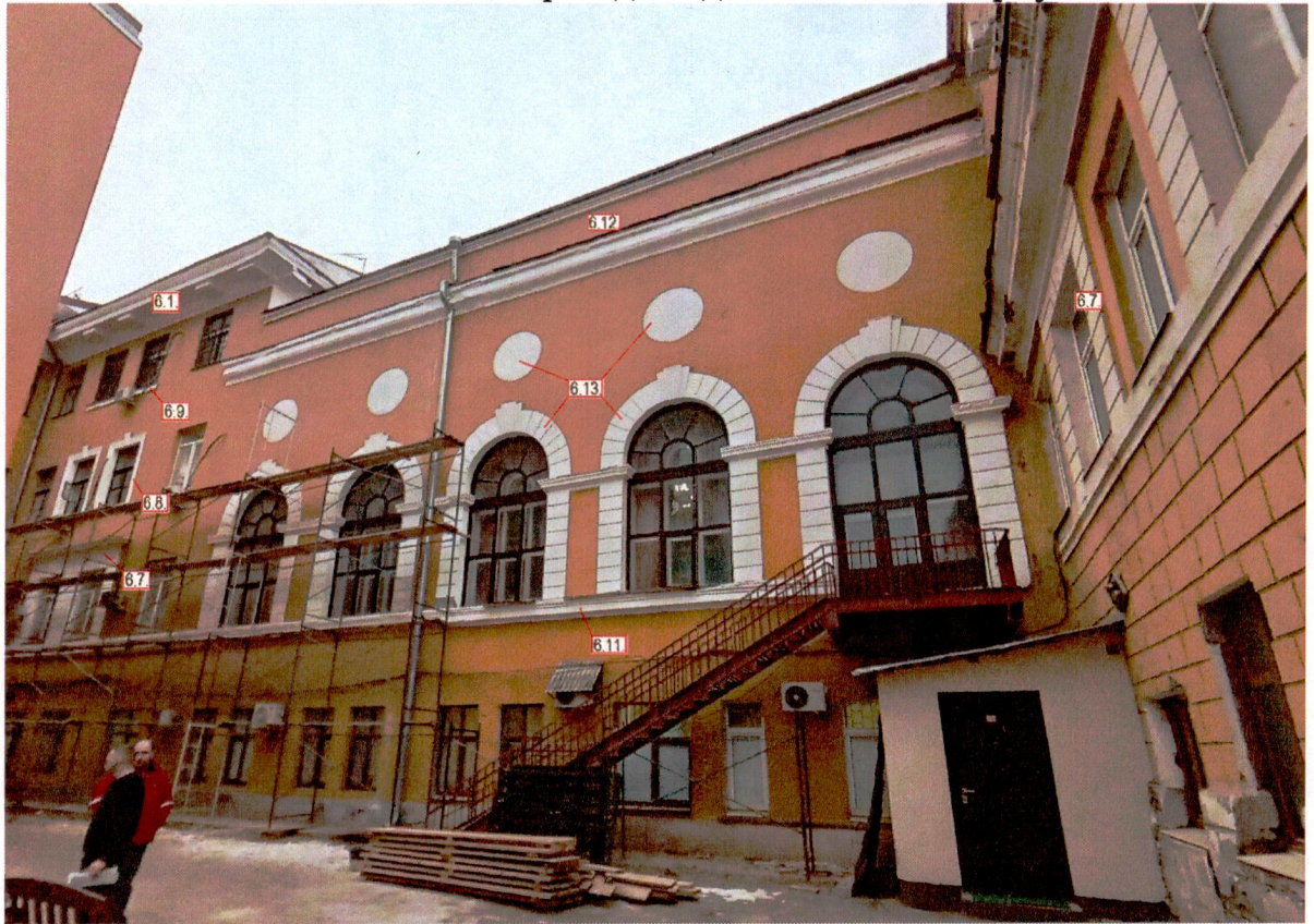
Юго-восточный фасад соединительного корпуса
