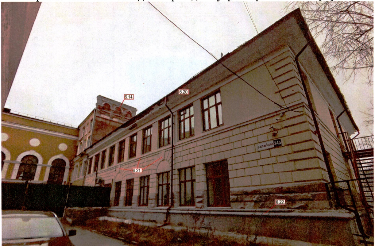
Правая часть юго-западного фасада внутриквартального корпуса
