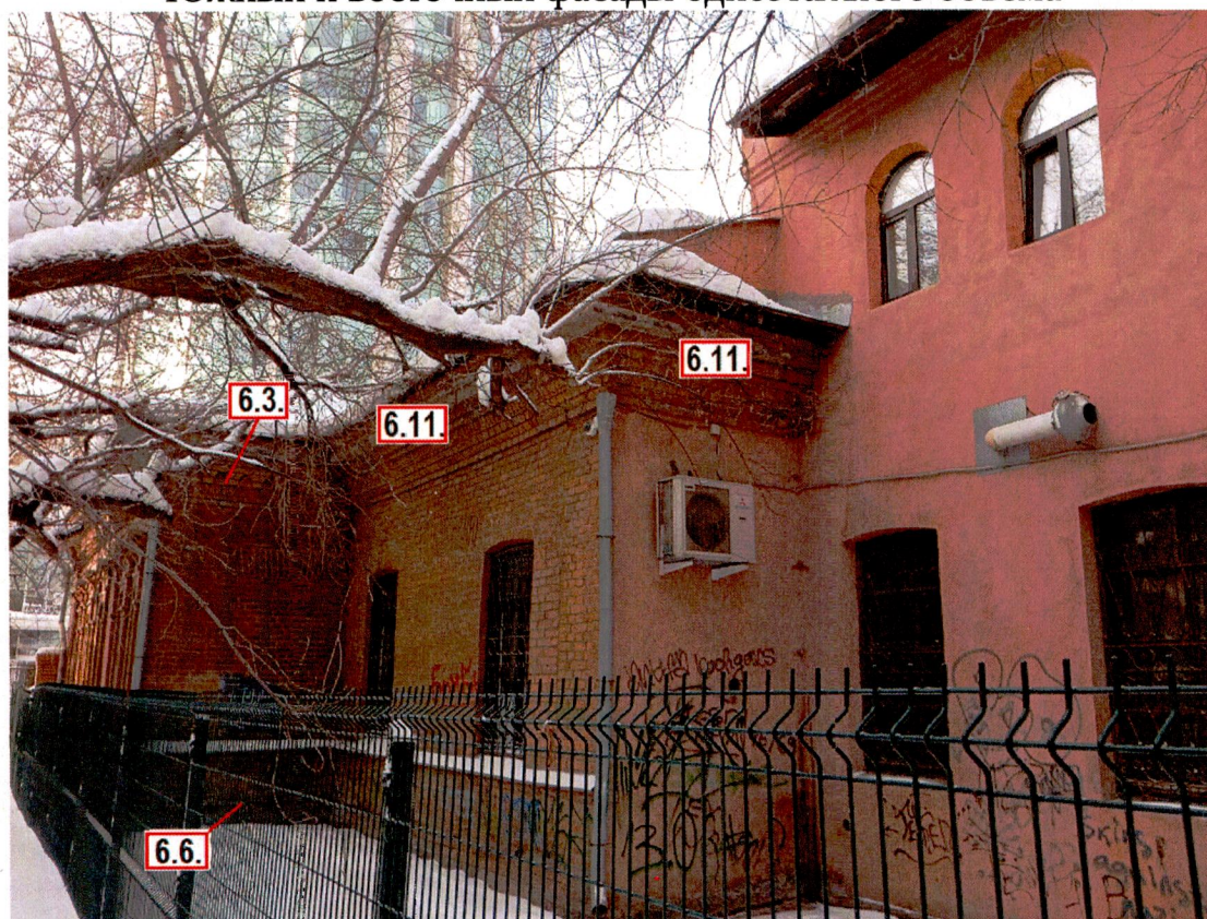
Южный и восточный фасады одноэтажного объема
