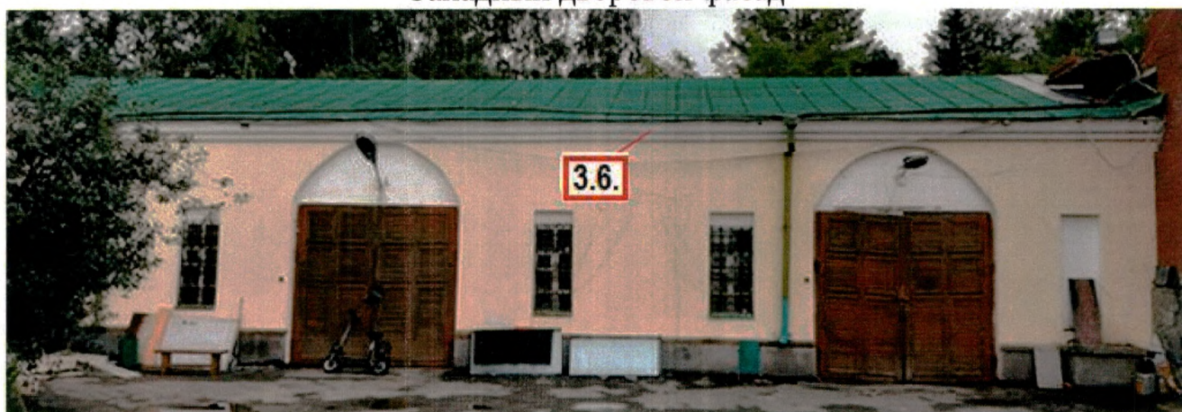
Западный дворовой фасад
