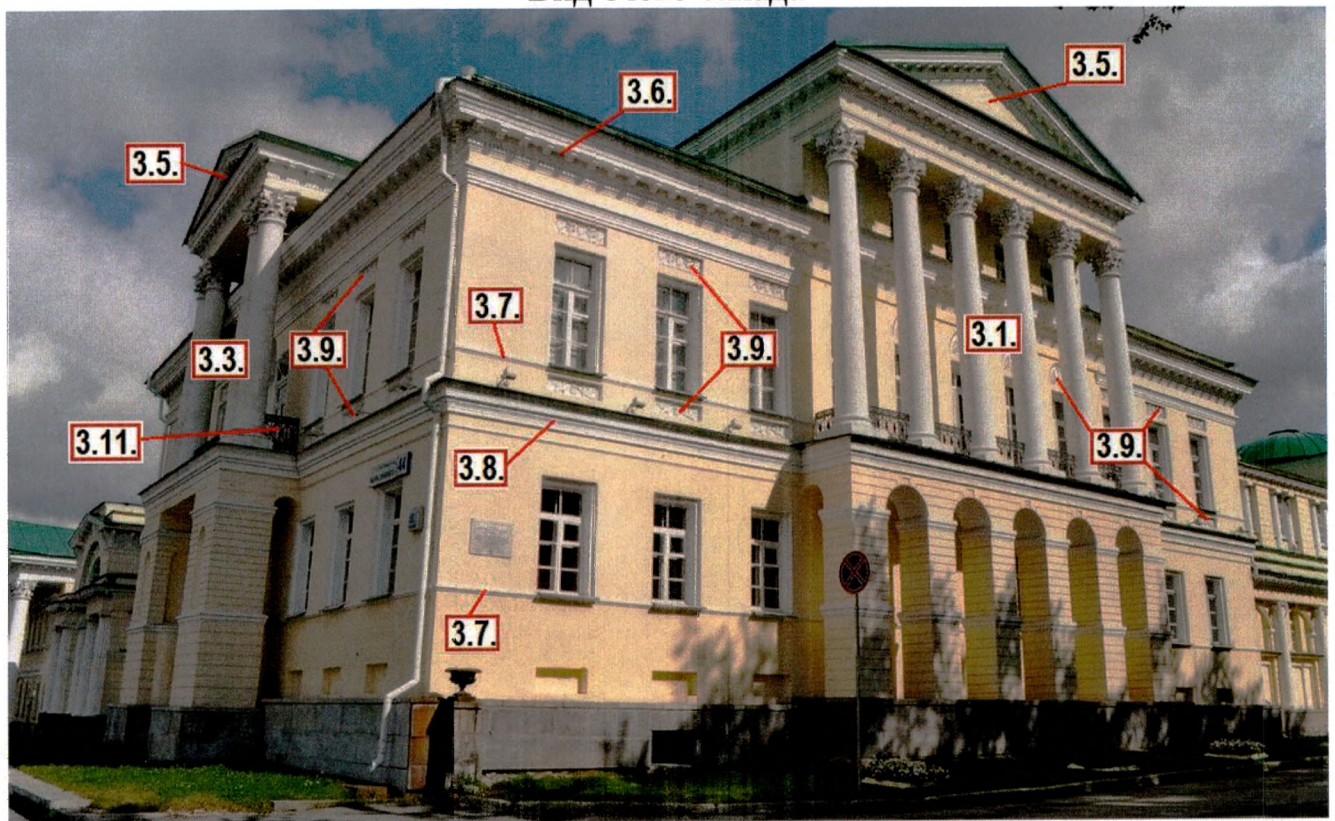
Вид с юго-запада
