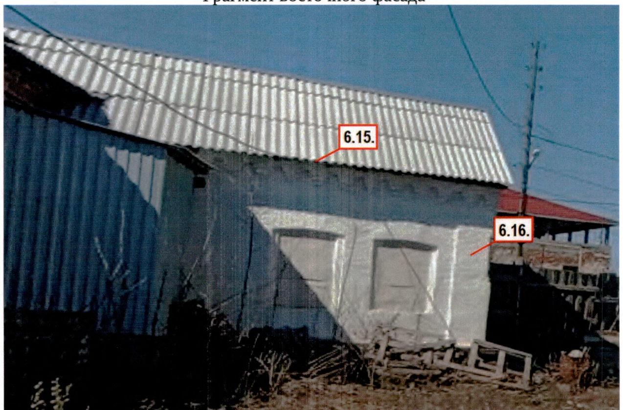
Фрагмент восточного фасада
