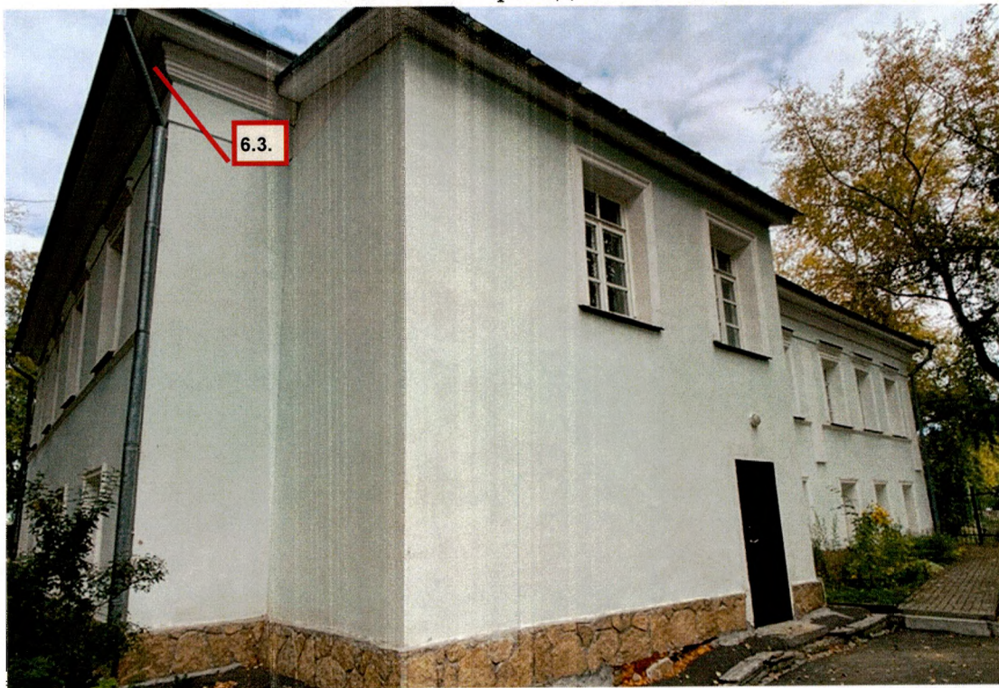
Юго-восточный фасад. Левая часть
