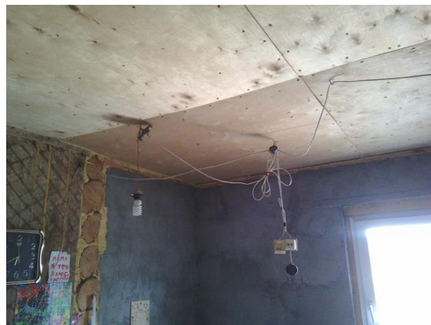
Фото 4-5. Примеры выявленных нарушений правил соблюдения электробезопасности.
