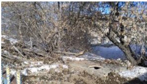
Фото 7. Люк за зданием школы № 91.
