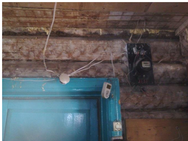
Фото 4-5. Примеры выявленных нарушений правил соблюдения электробезопасности.
